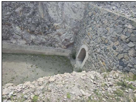
图 2-13 排水涵洞出口
