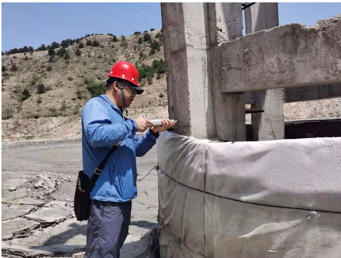
图 2-15 排水井混凝土强度检测
