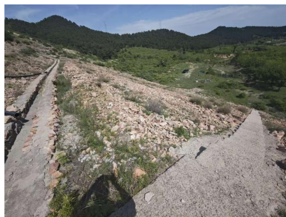
图 2-4 拦挡坝马道排水沟
