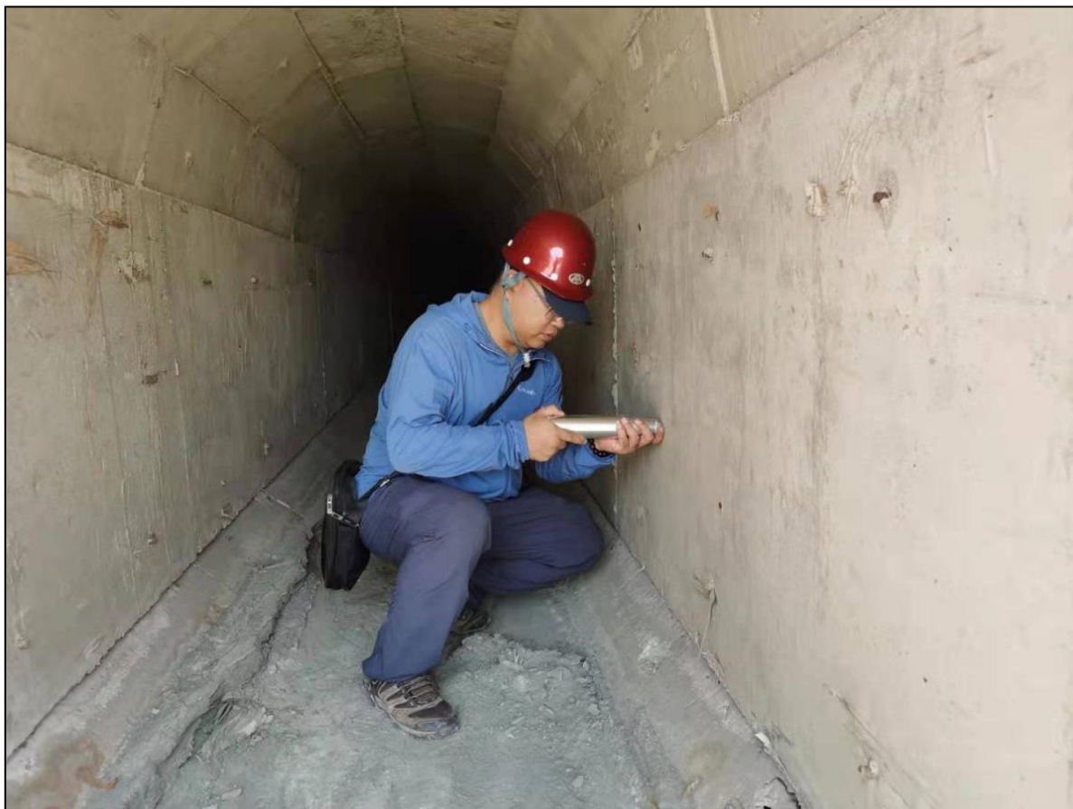
图 2-14 排水涵洞混凝土强度检测
