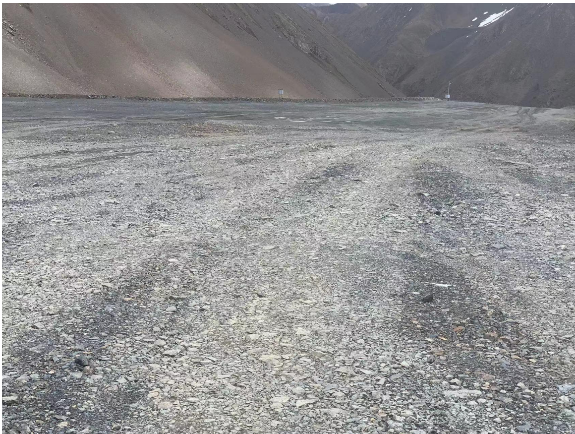
图 2-18 排土作业平台反坡
