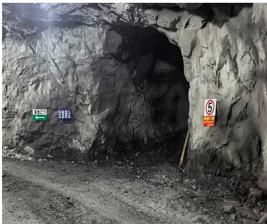
5020m~5210m 斜坡道躲避硐室、安全警示标志
