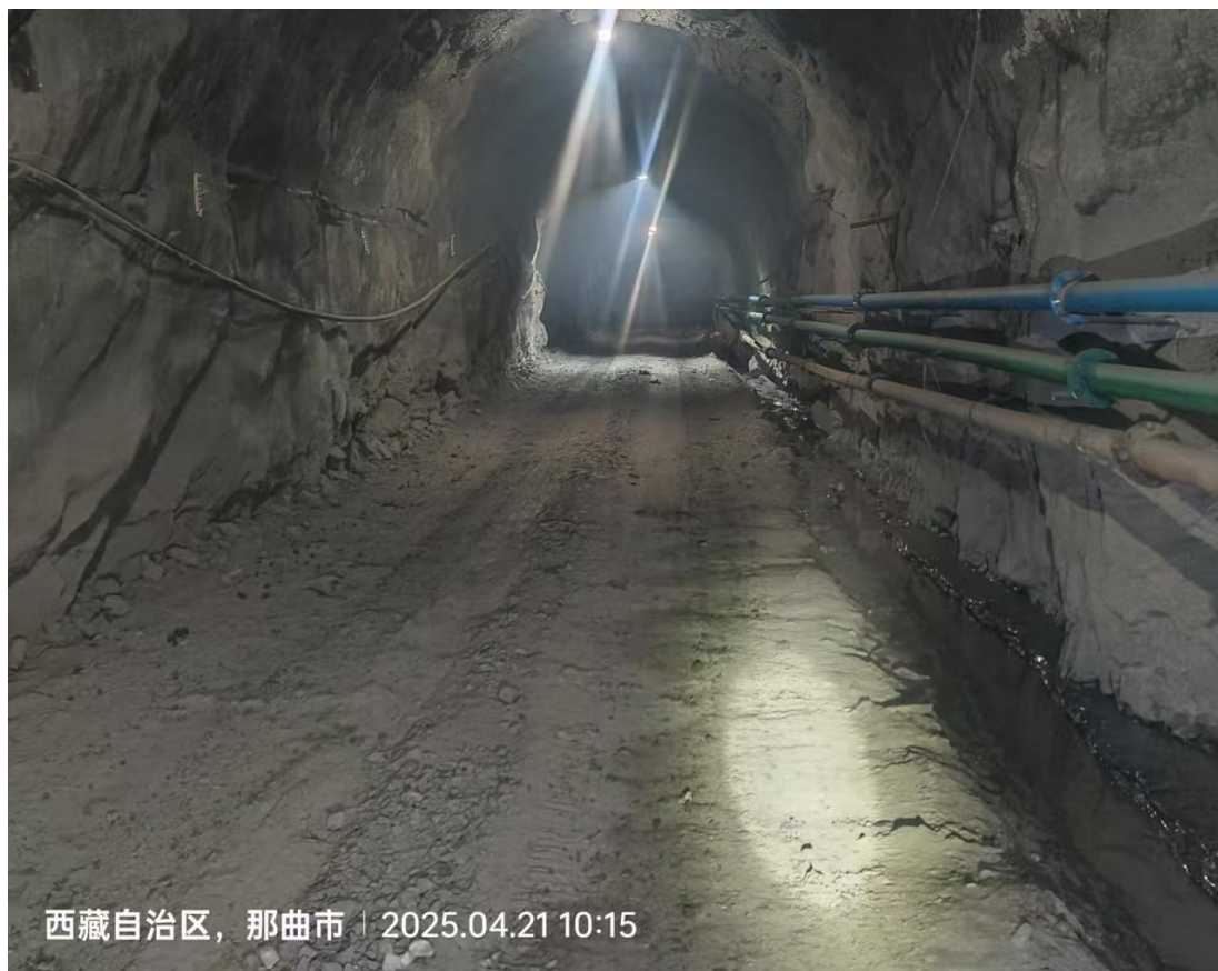
运输巷道、风水管路、电缆架设、巷道顶部照明
