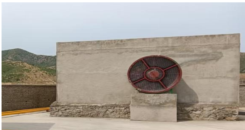
图 2-13 回风竖井风机房
