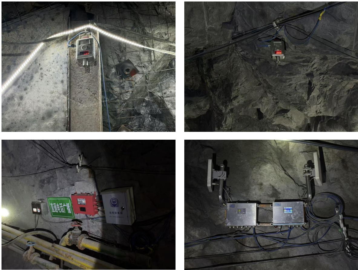
图 2-20 井下传感器、应急广播和人员定位基站
