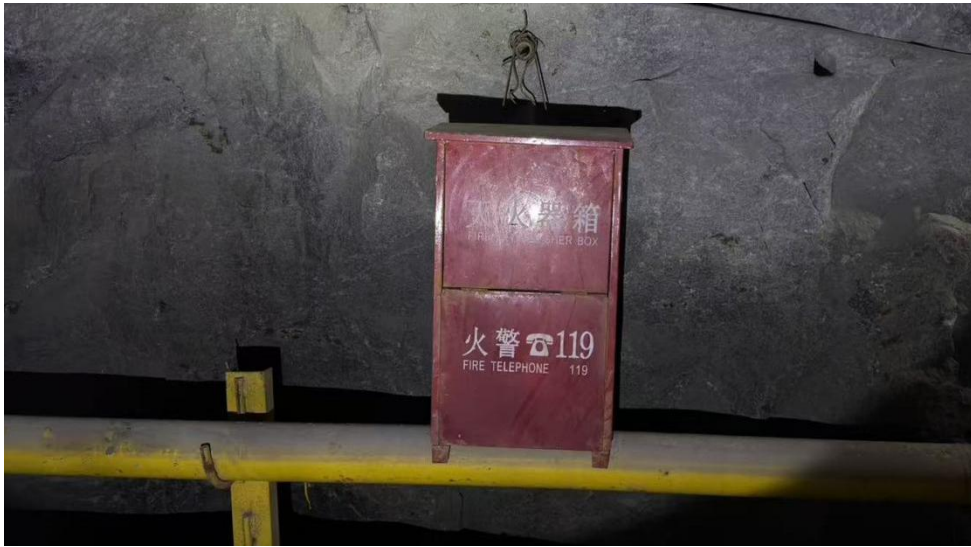
图 2-18 斜坡道内灭火器箱
