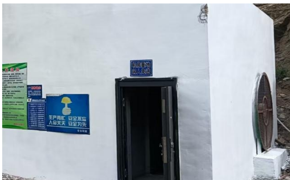
图 2-14 回风斜坡道 1 风机房
