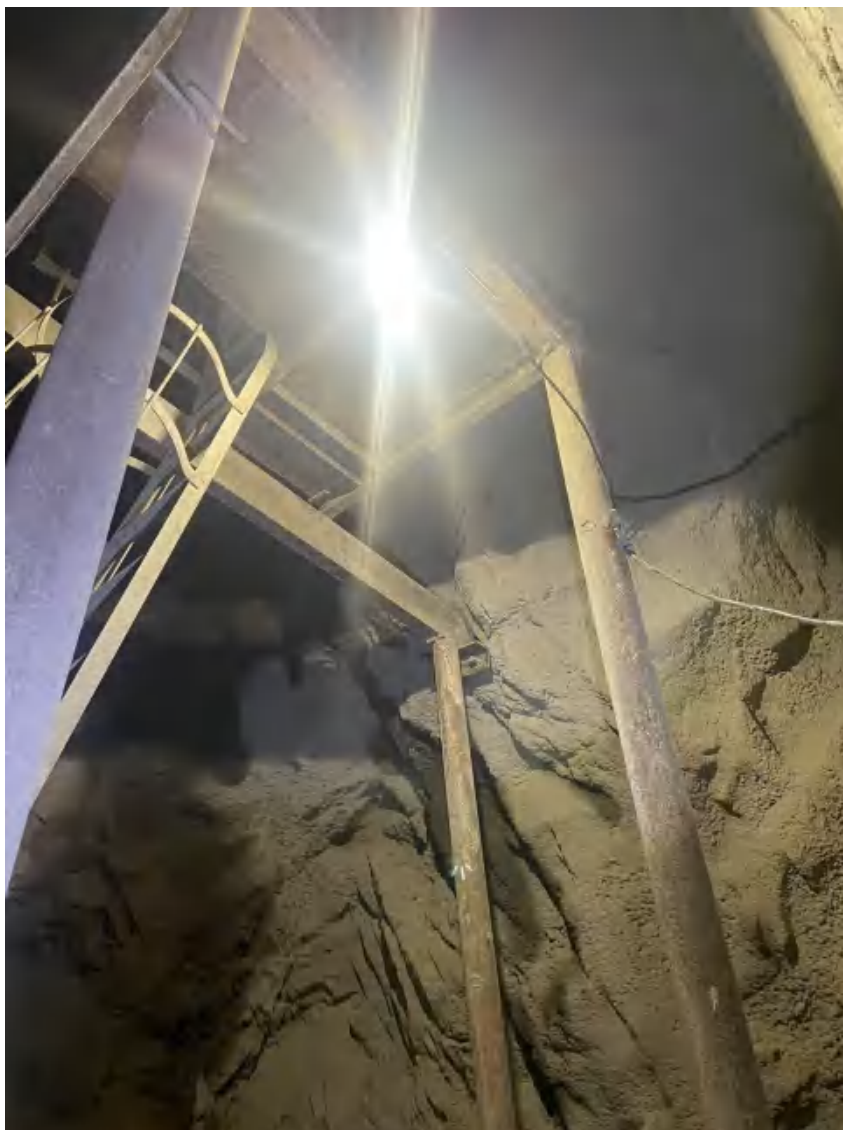
图 2-9 -269m 拉底水平 3#采区回风天井梯子间
