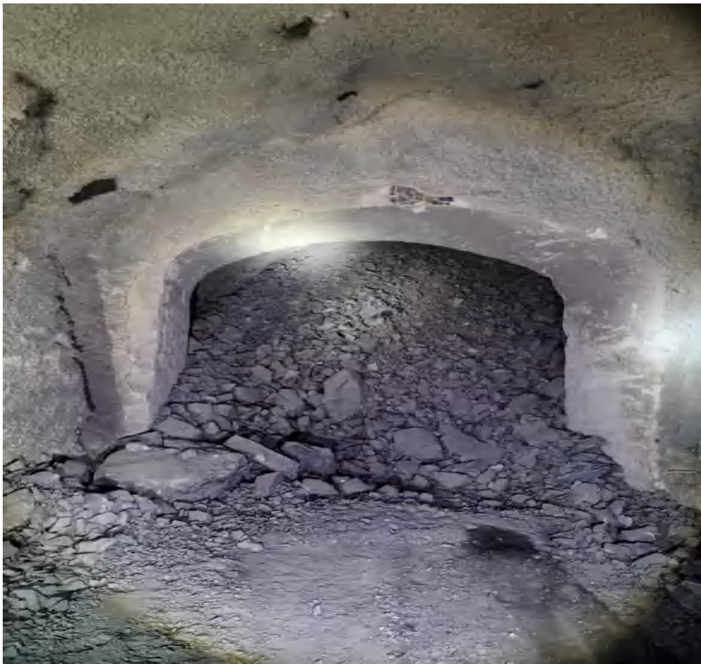
图 2-6 西矿段聚矿槽
