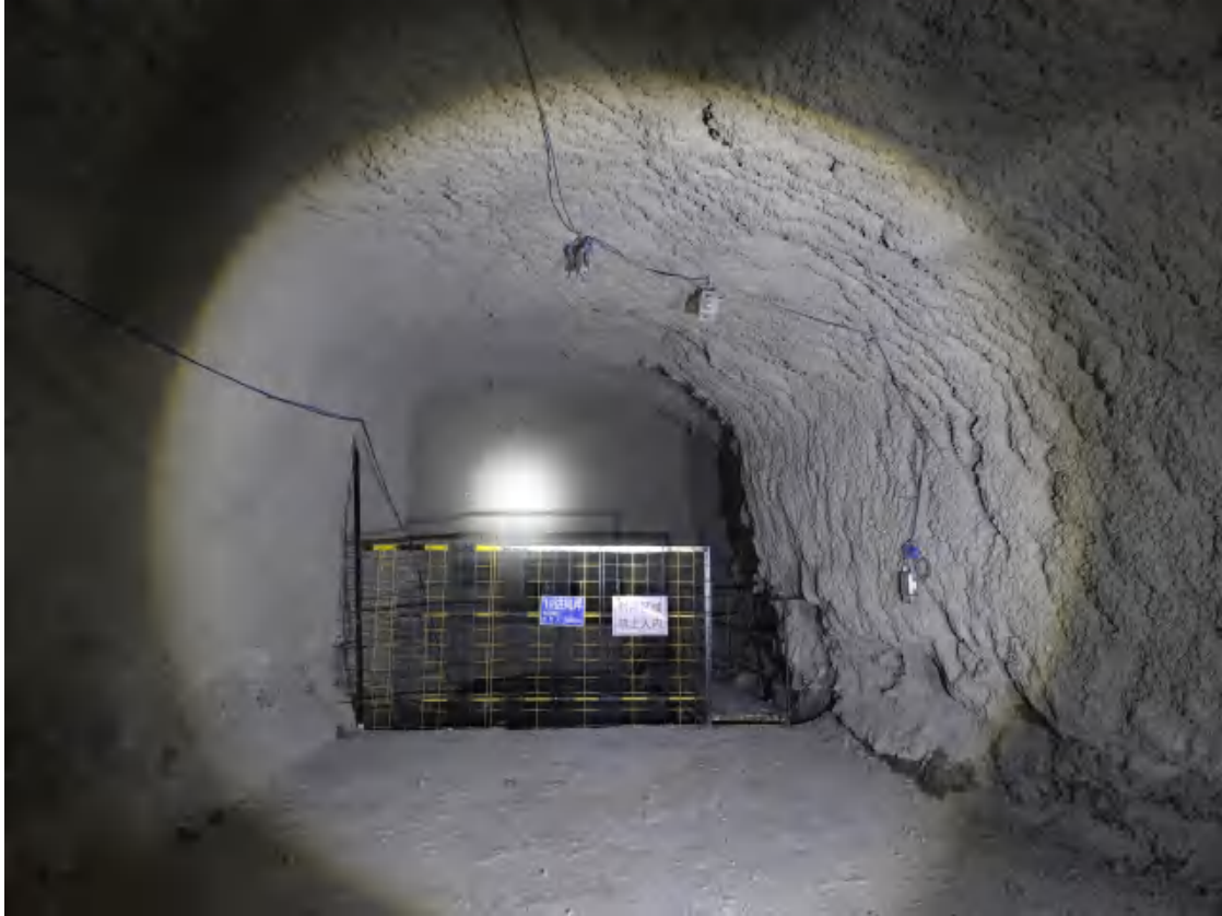
图 2-10 -285m 出矿水平 1#采区进风井安全出口
