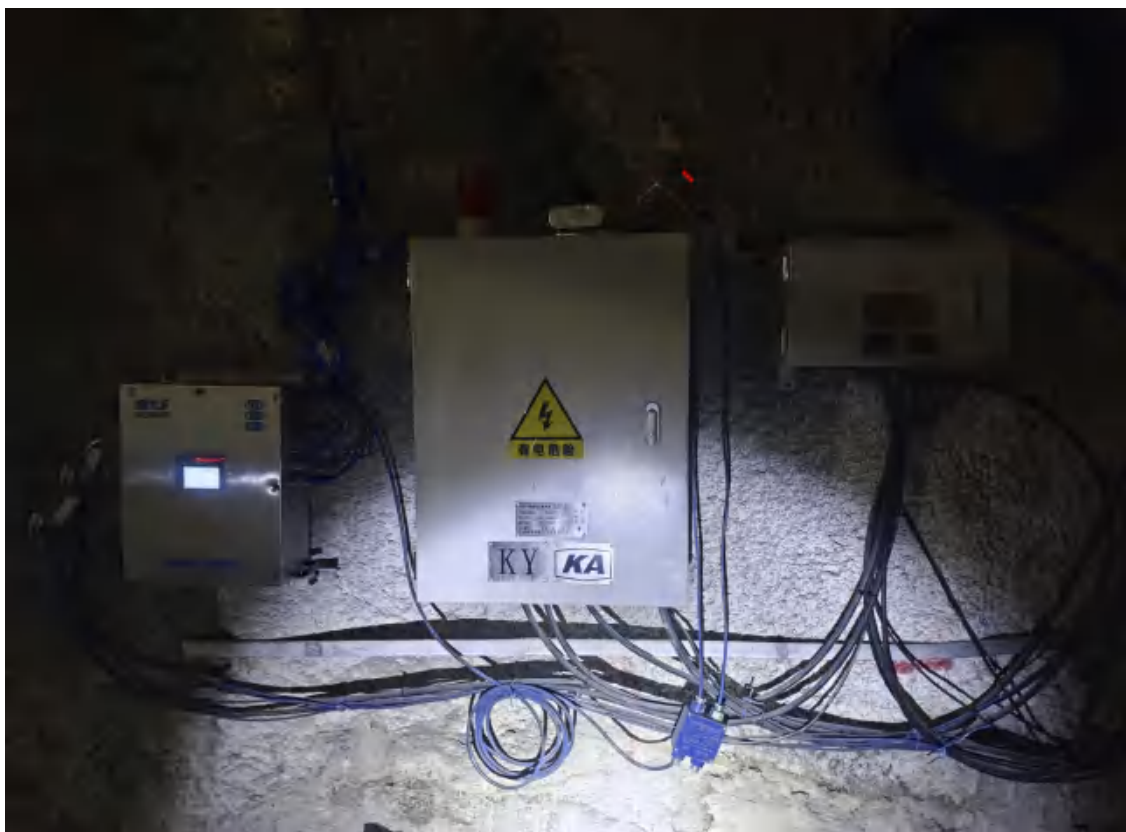
图 2-33 -303m 进风水平监控分站
