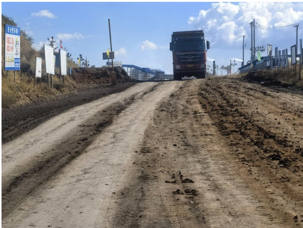
图 3.3-1 采场三级运输道路及安全车挡
