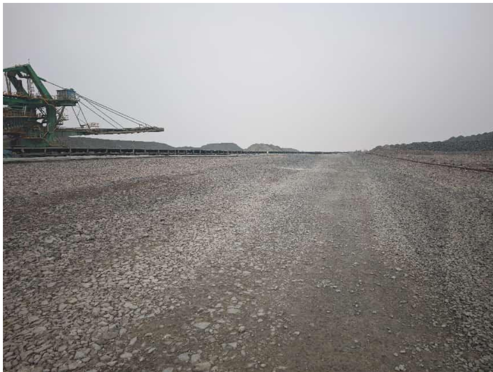
图 2.5.2-7 排土场顶部平台
