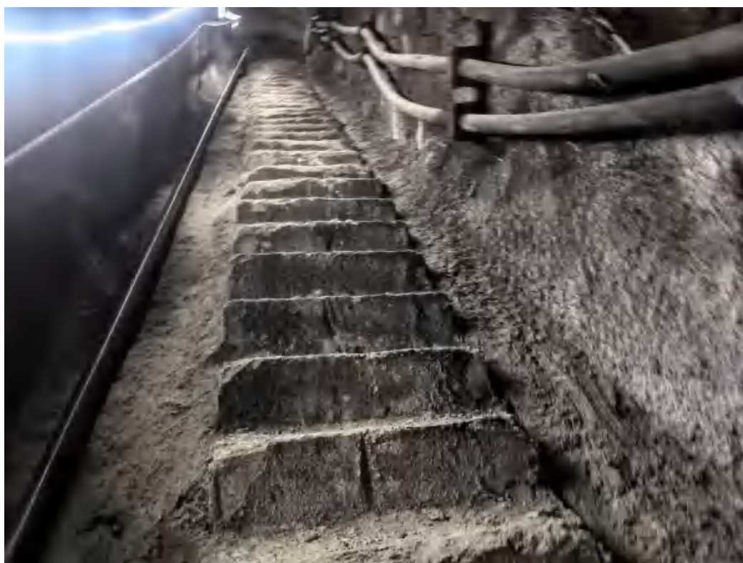
图 3.4-5 0m 中段水泵房内管子斜道出口
