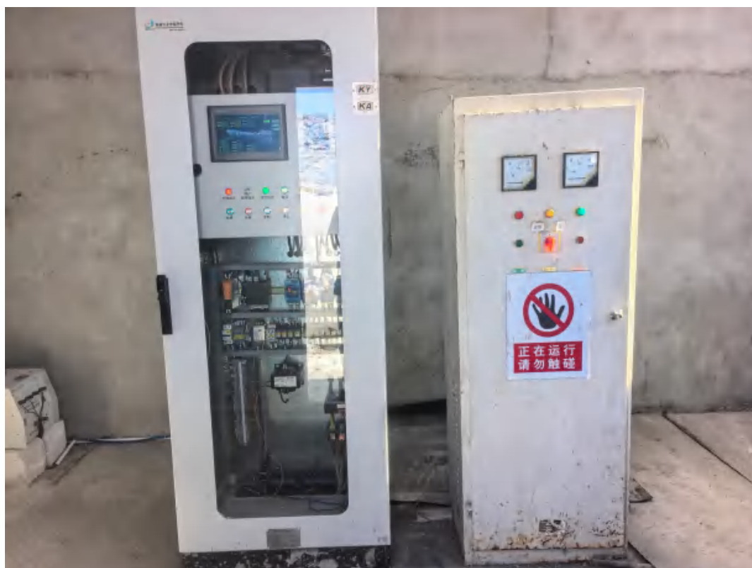
图 3.5-8 北回风斜井控制系统
