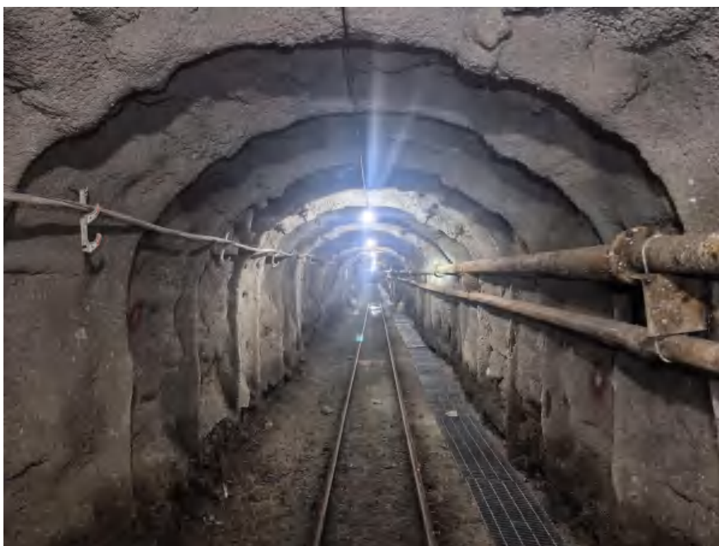
图 3.2-14 350m 中段支护
