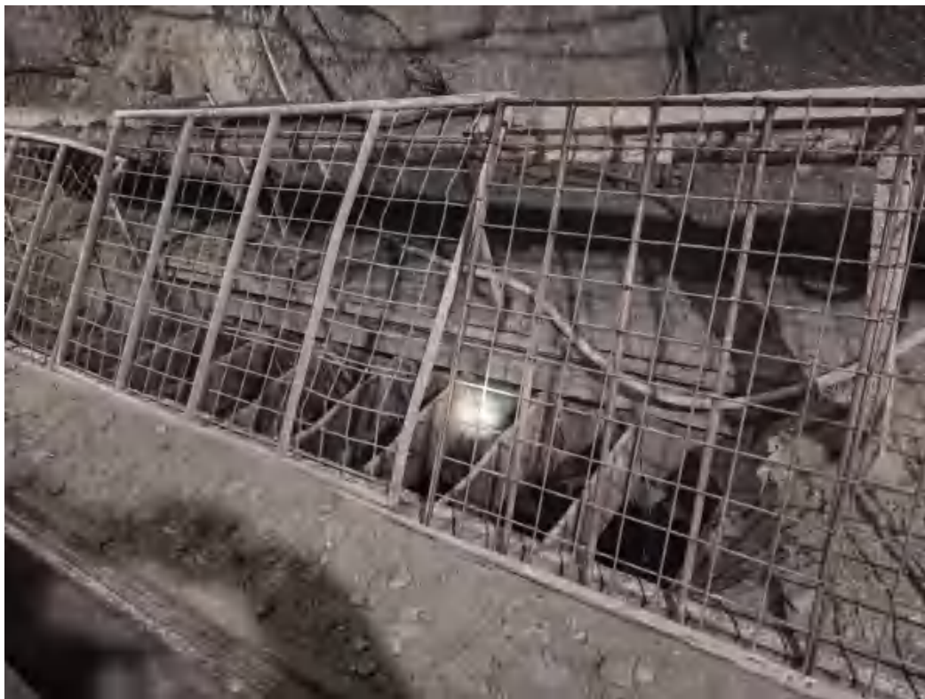
图 3.3-12 主溜井顶部安全护栏及格栅
