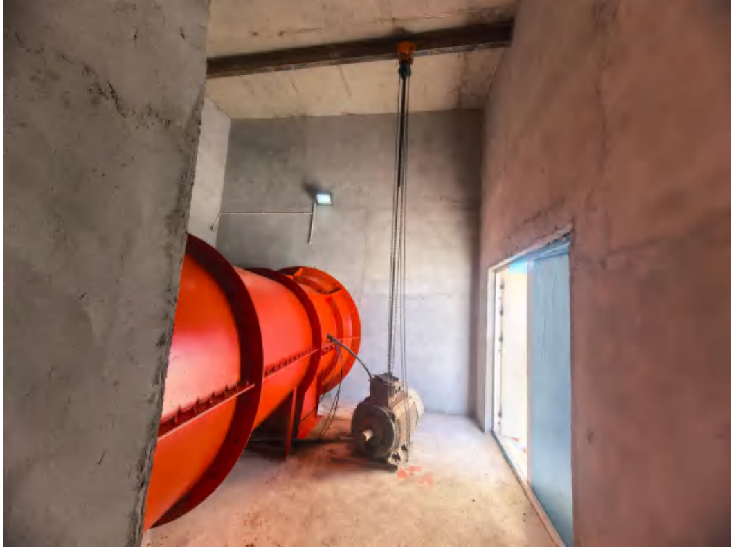
图 3.5-11 通风机电机快速转换装置
