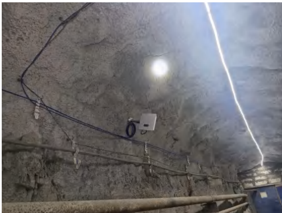
图 3.9-3 井下人员定位系统分站
