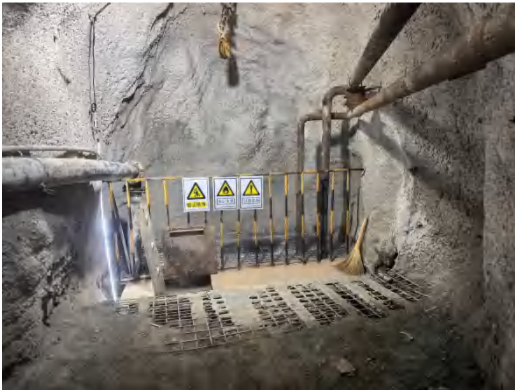
图 3.12-5 井下通风天井处安全风险告知牌
