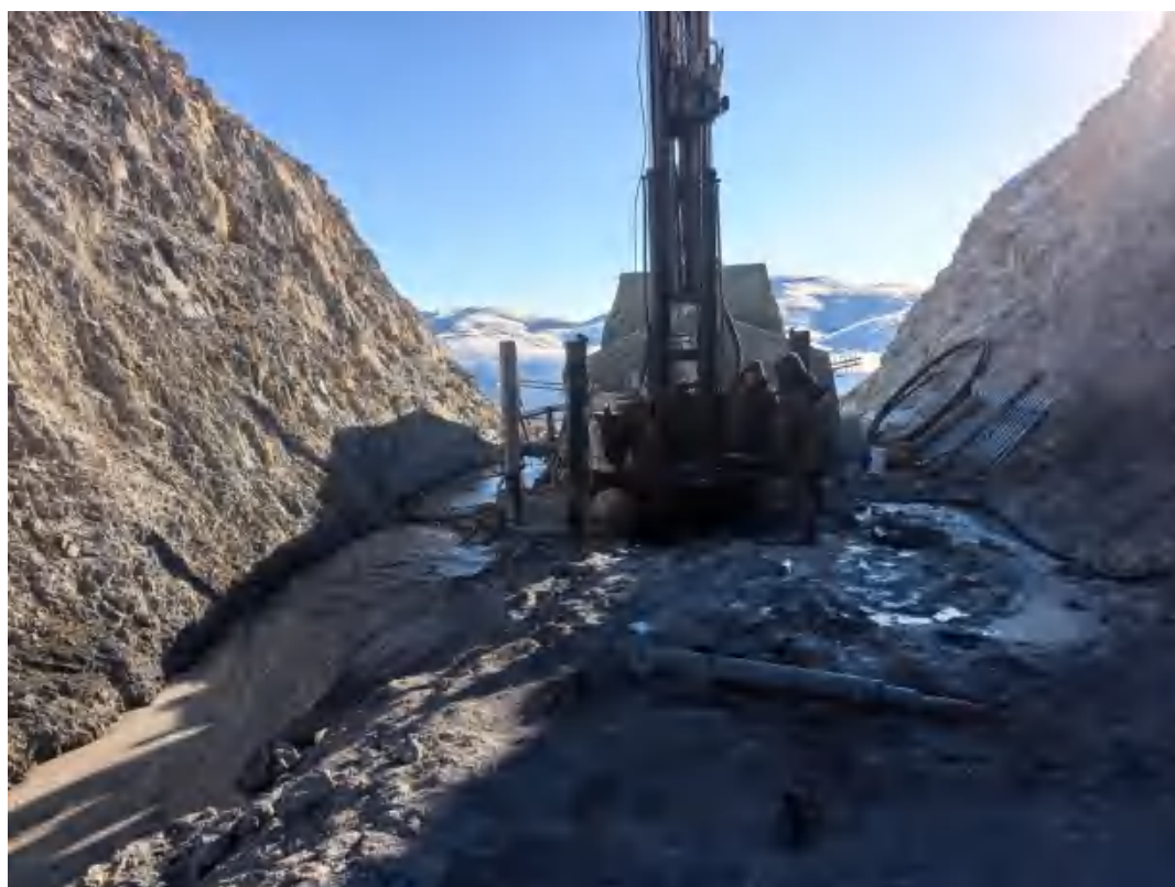
图 3.4-7 地表帷幕止水钻孔施工
