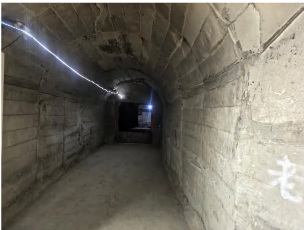
图 3.2-18 0m 水泵房支护
