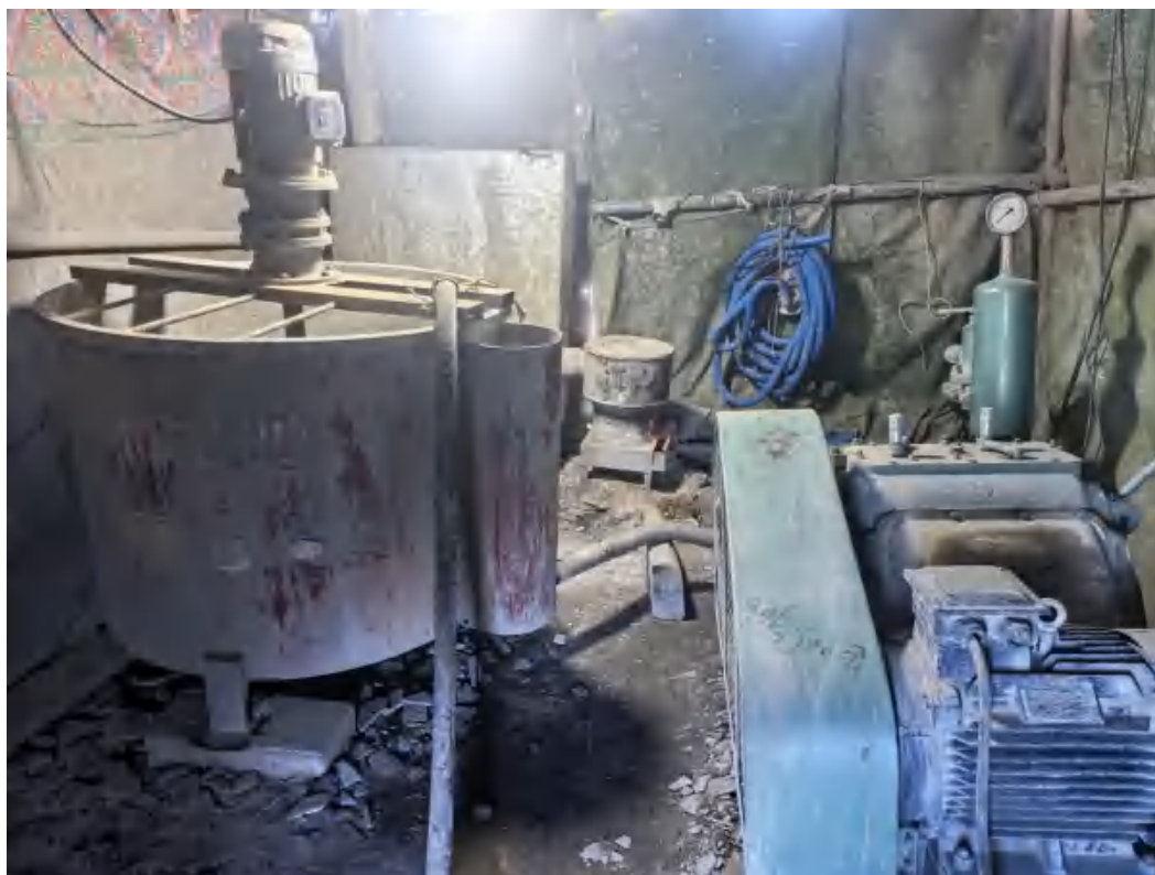
图 3.4-8 地表帷幕止水注浆施工
