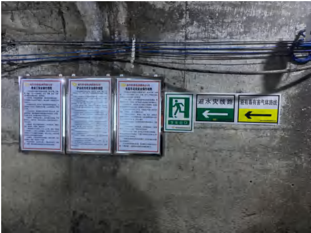
图 3.12-7 井下作业操作规程、避灾线路指示牌
