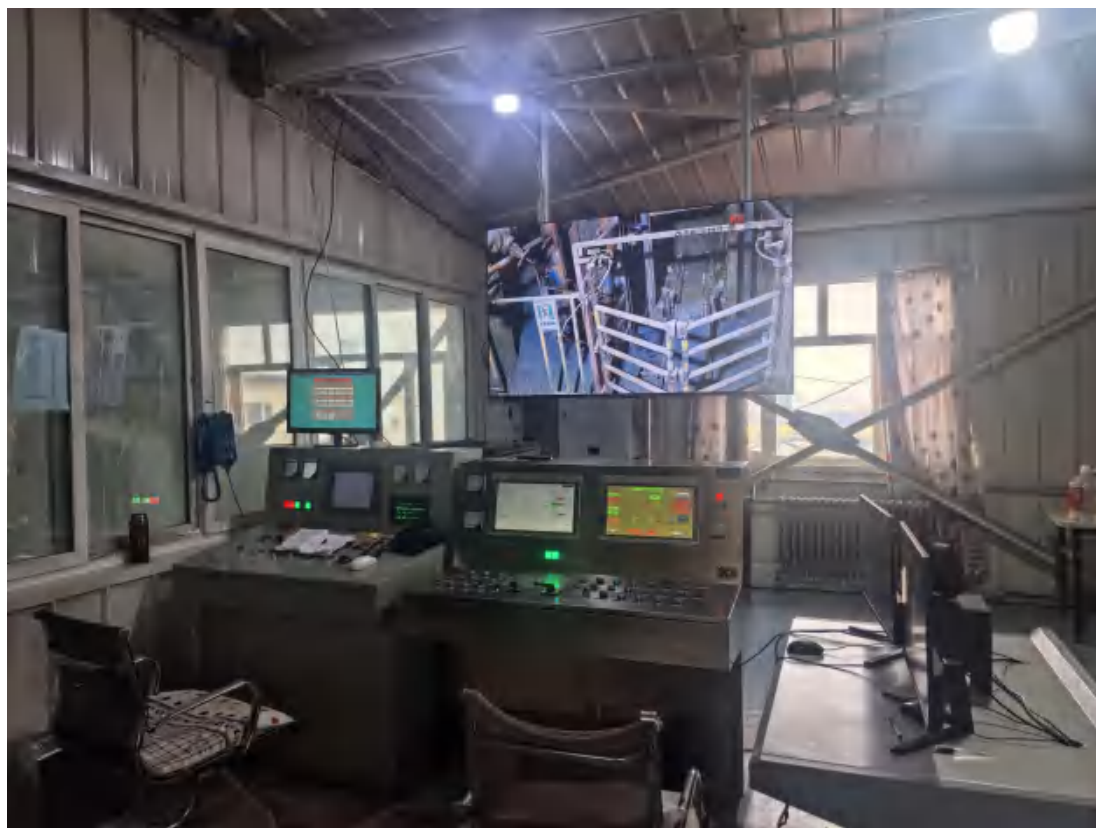
图 3.3-9 5 号井提升机操作台
