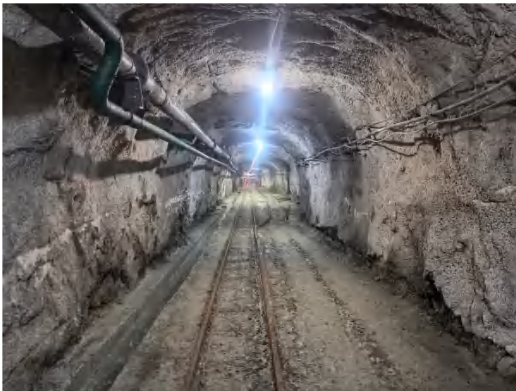
图 3.2-13 0m 中段锚网喷支护
