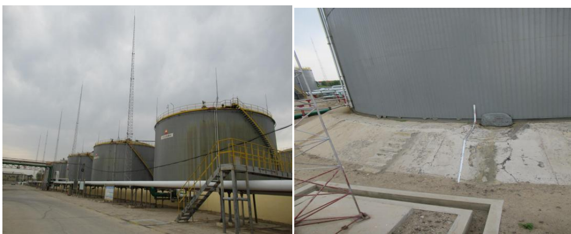
图 2.2.3-23 曙五联合站代表性防雷接地照片
