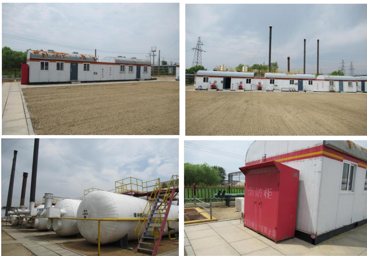
图 221-7 18 号站现场勘察照片
