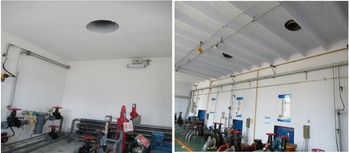
图 2.2.3-8 曙一联合站代表性机械通风照片
