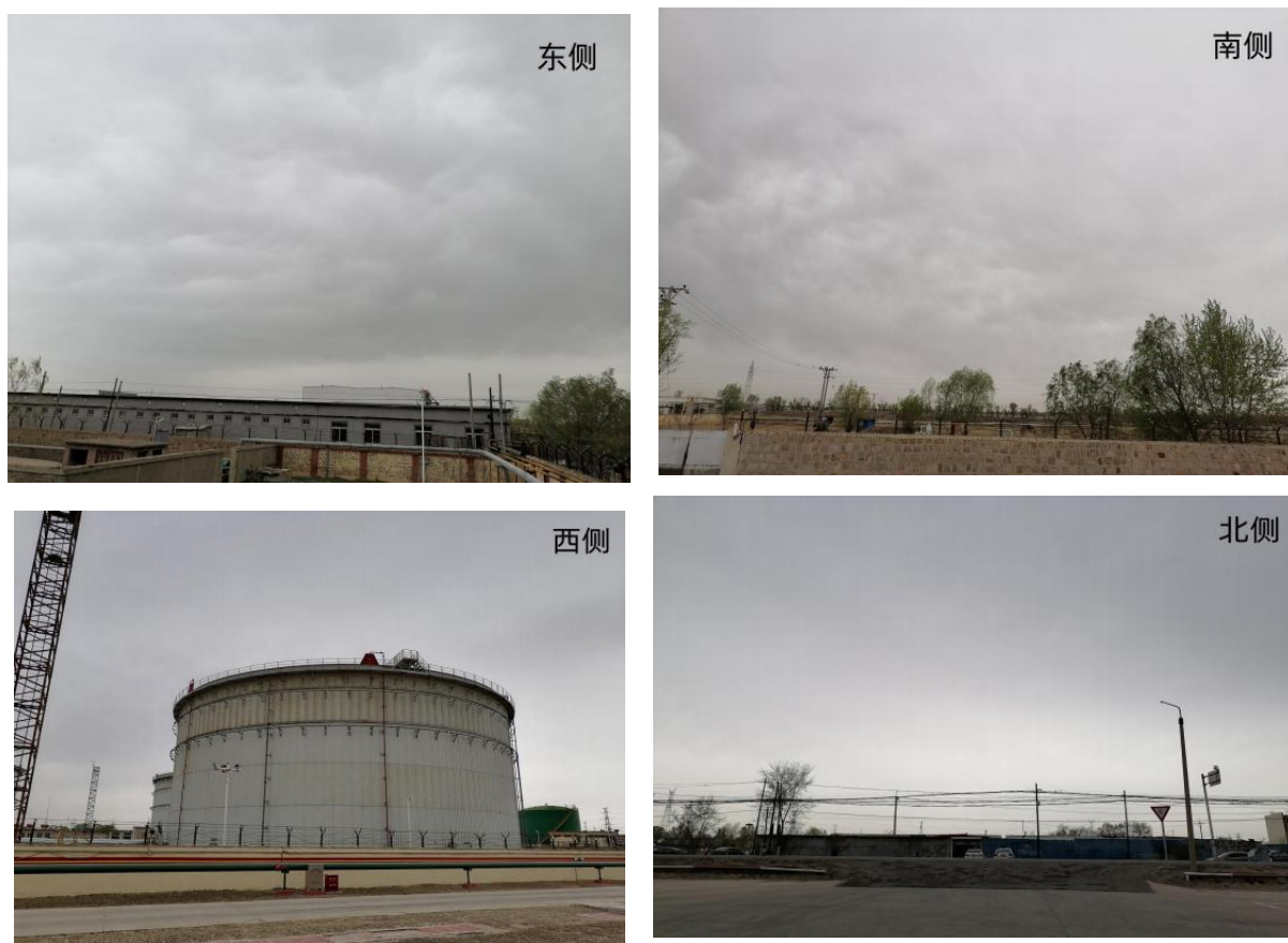
图 2.2.3-3 曙一联合站现场勘察周边环境照片
