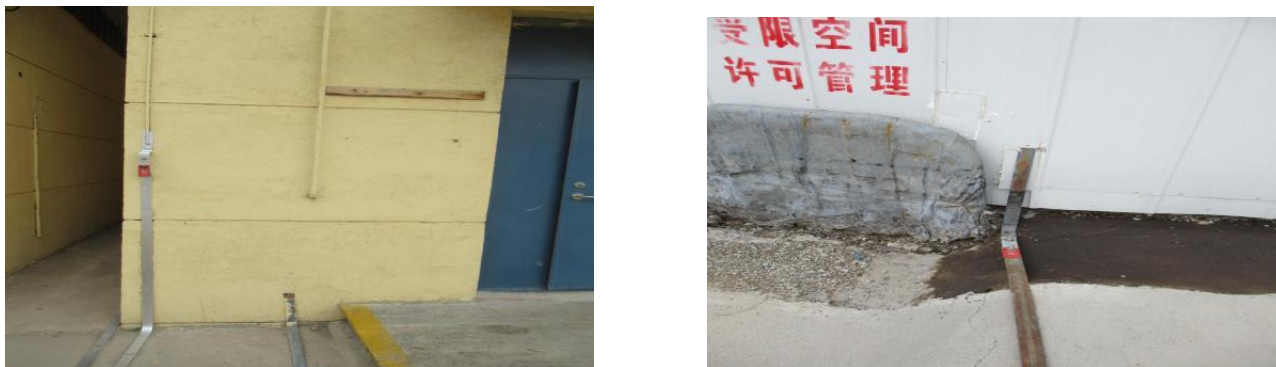
图 2.2.3-15 曙四联合站代表性防雷接地照片
