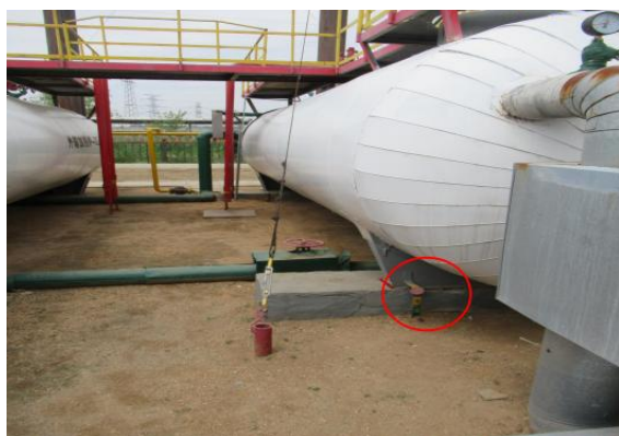
图 2.2.1-8 采油站、转油站代表性防雷接地图
