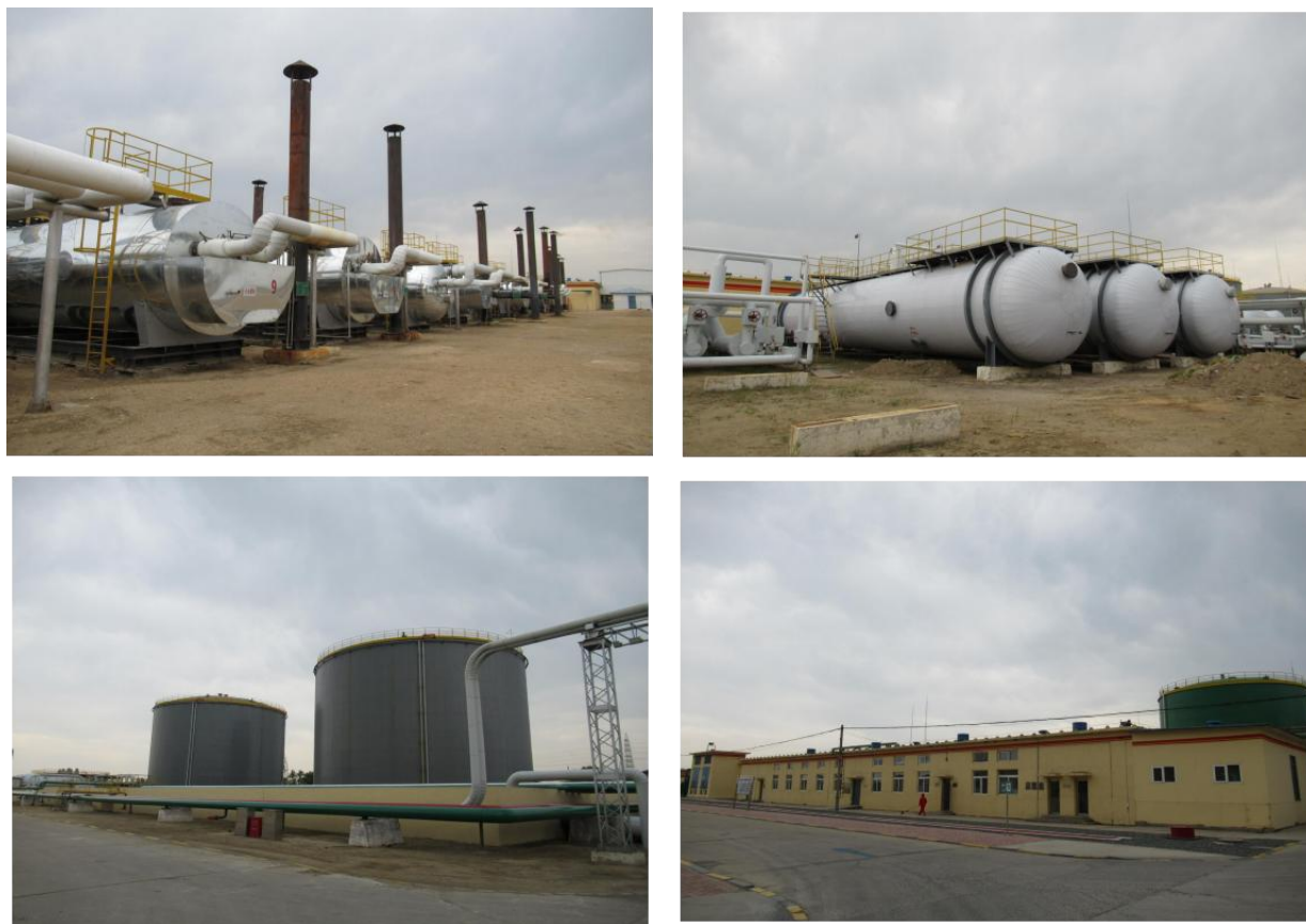
图 2.2.3-19 曙五联合站现场勘察照片
