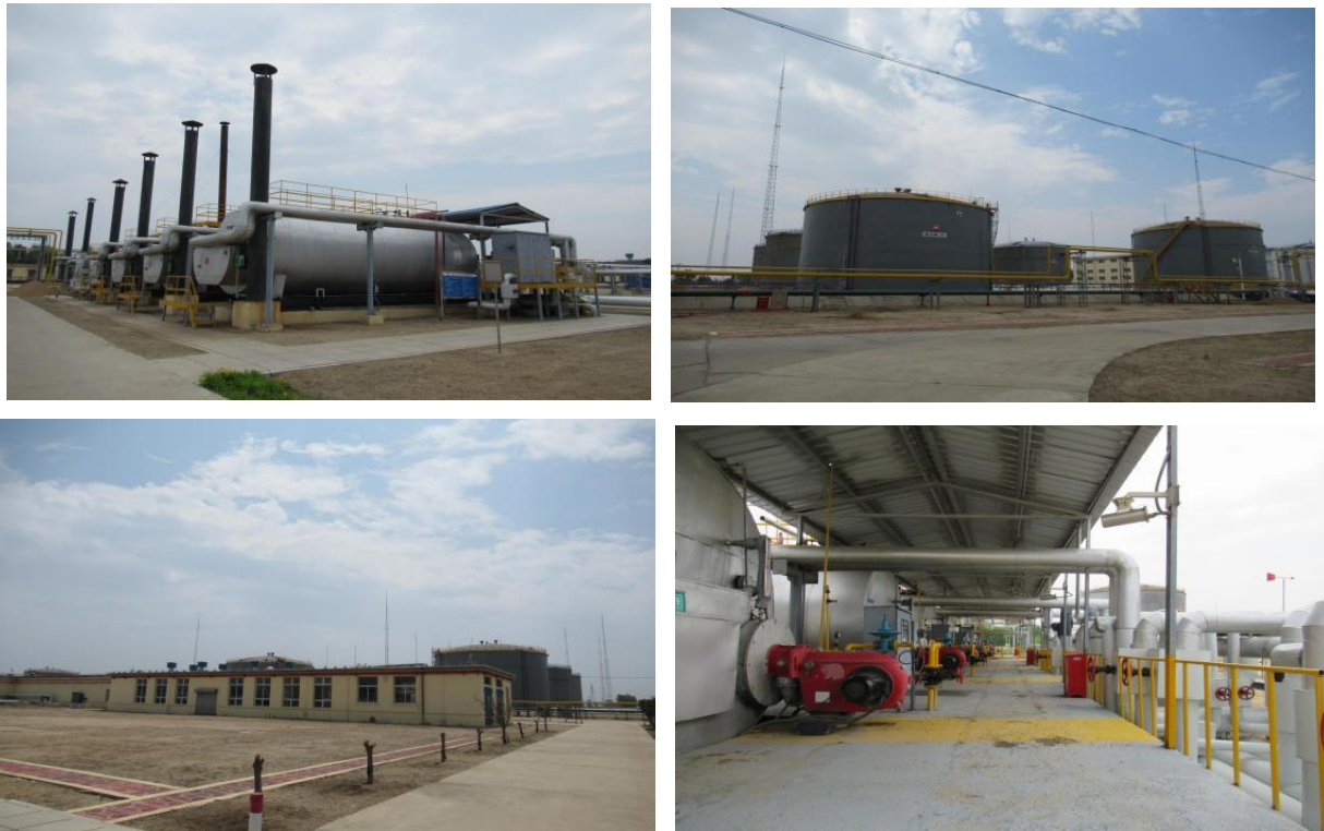
图 2.2.3-2 曙一联合站现场勘察照片
