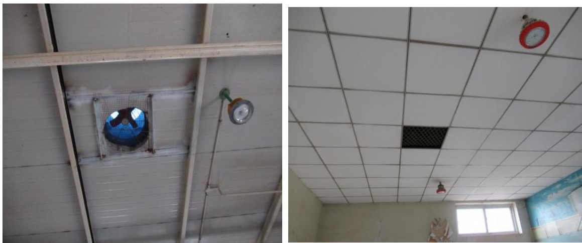
图 2.2.3-24 曙五联合站代表性机械通风照片
