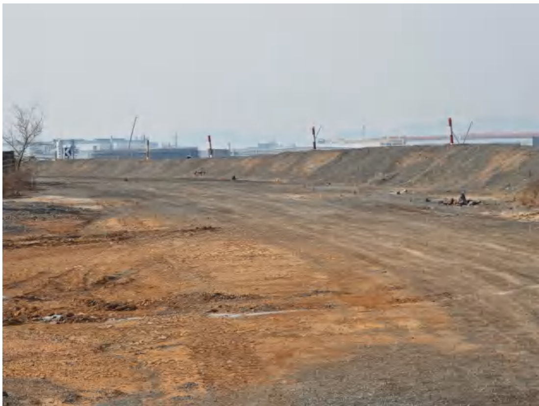
图 2-8 运输道路一侧安全车挡
