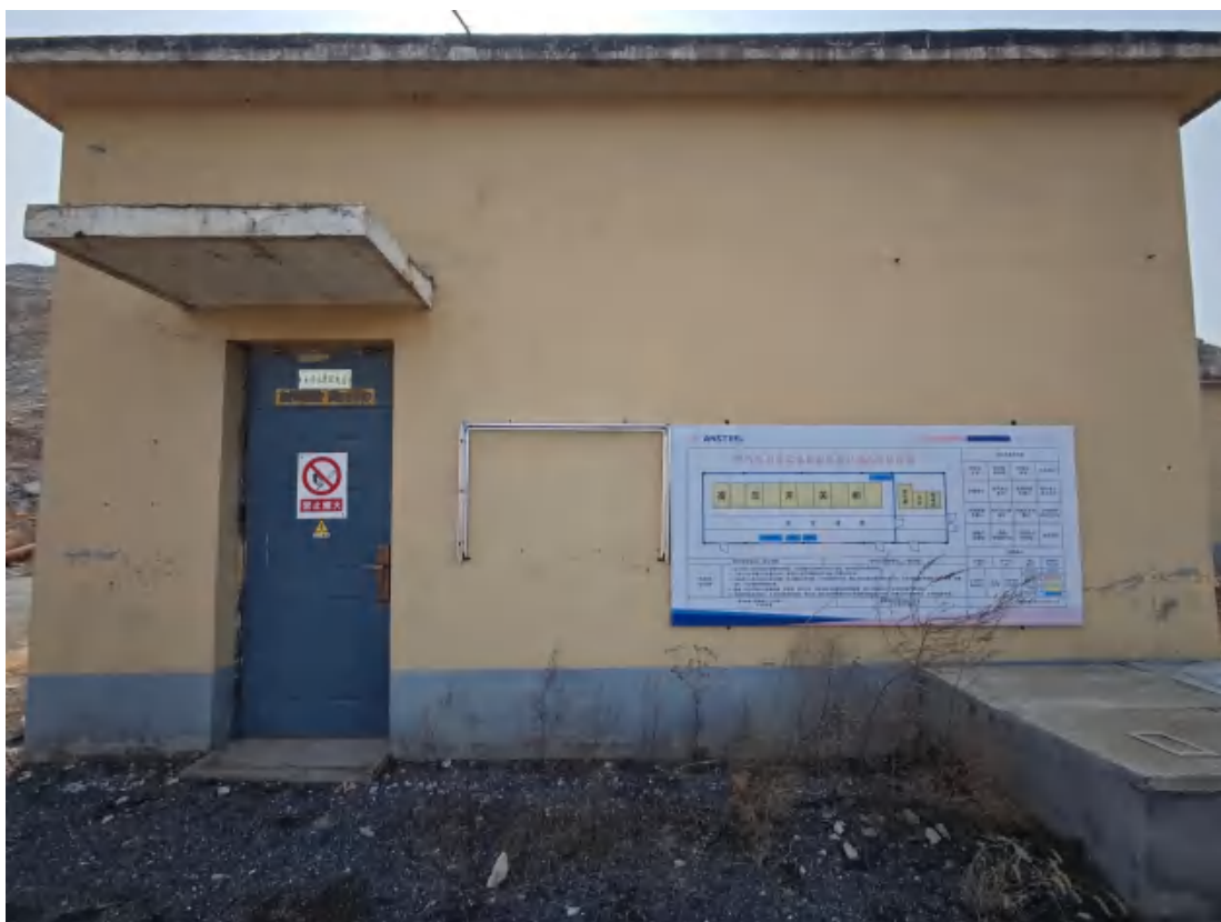
图 2-20 采场水泵配电室
