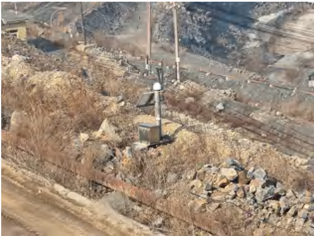
图 2-6 露天采场边坡在线监测
