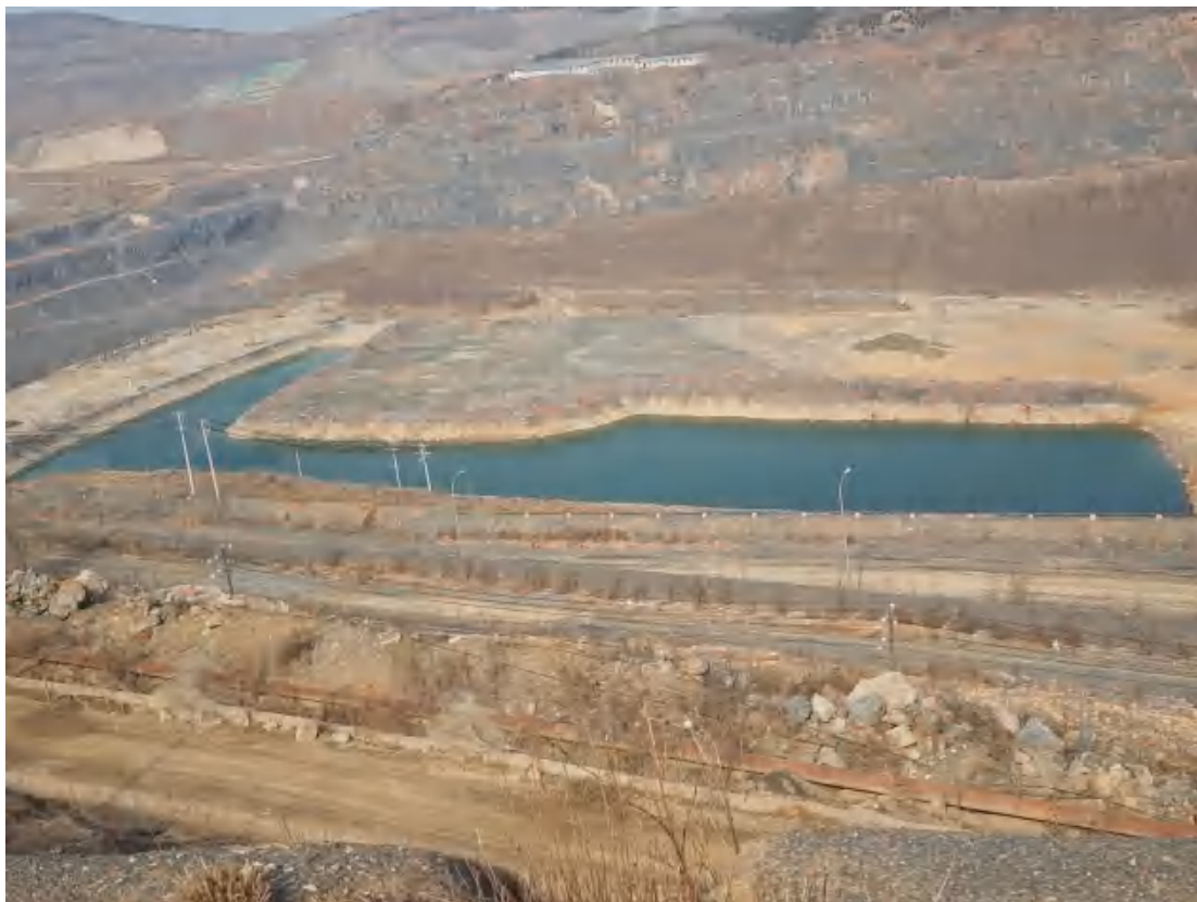
图 2-17 露天坑底集水池
