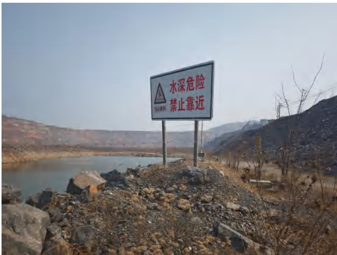
图 2-18 集水池的安全围栏和警示标志牌
